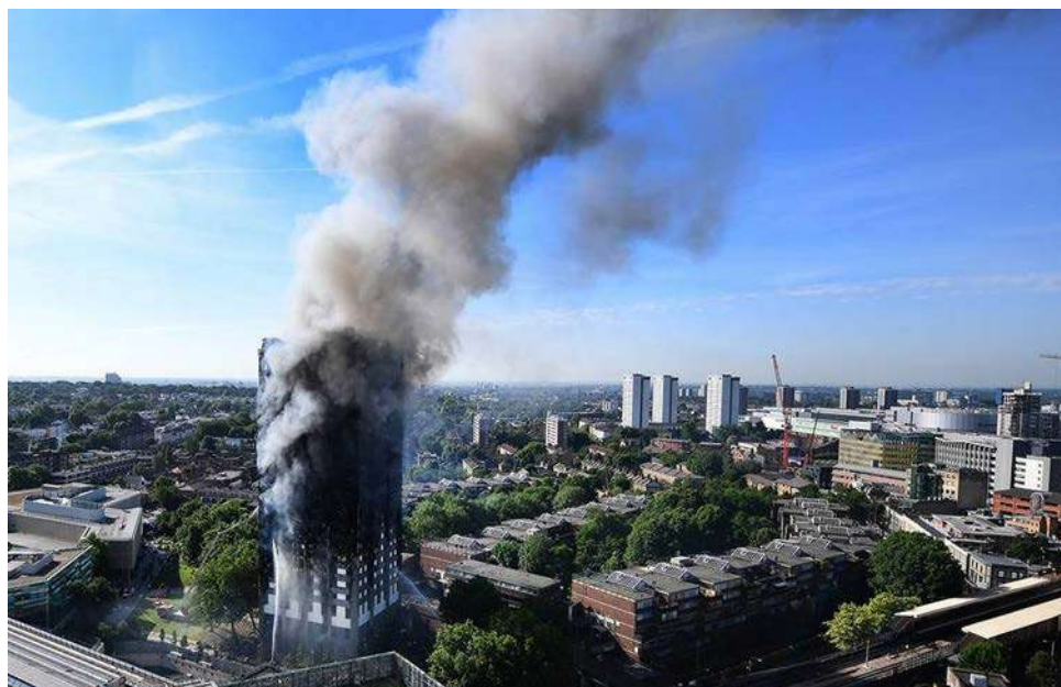
Рис.1 Пожар в Grenfell Tower в Лондоне
